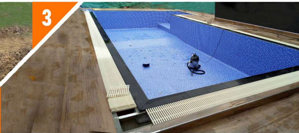
ติดตั้งรางยึดไวน์ล เทล่อรางน้ำล้น ติดตั้งขอบสระหินแกรนิต พร้อมติดตั้งไวน์ล(วัสดุรับน้ำ) Laying granite pool deck - ready for vinyl lining and Vinyl lining complete
