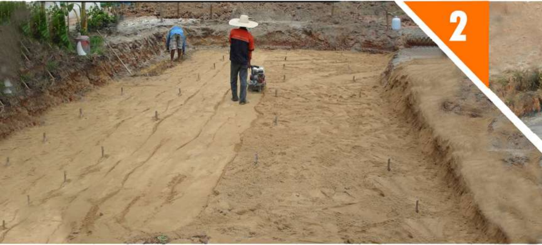
วางผังสระว่ายน้ำ และขุดดิน ลงเสาเข็ม ปรับพื้นที่ พร้อมวางแนวท่อระบบ Layout and Excavation - Install piles and layout system line
