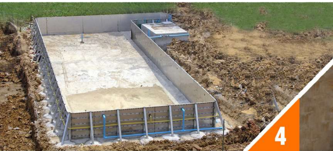
ติดตั้งโครงสร้างรับน้ำหนัก ติดตั้งงานระบบ Install SPC Panel Pool Wall Lock SPC wall panel and pool slab with Concrete lock to single piece
