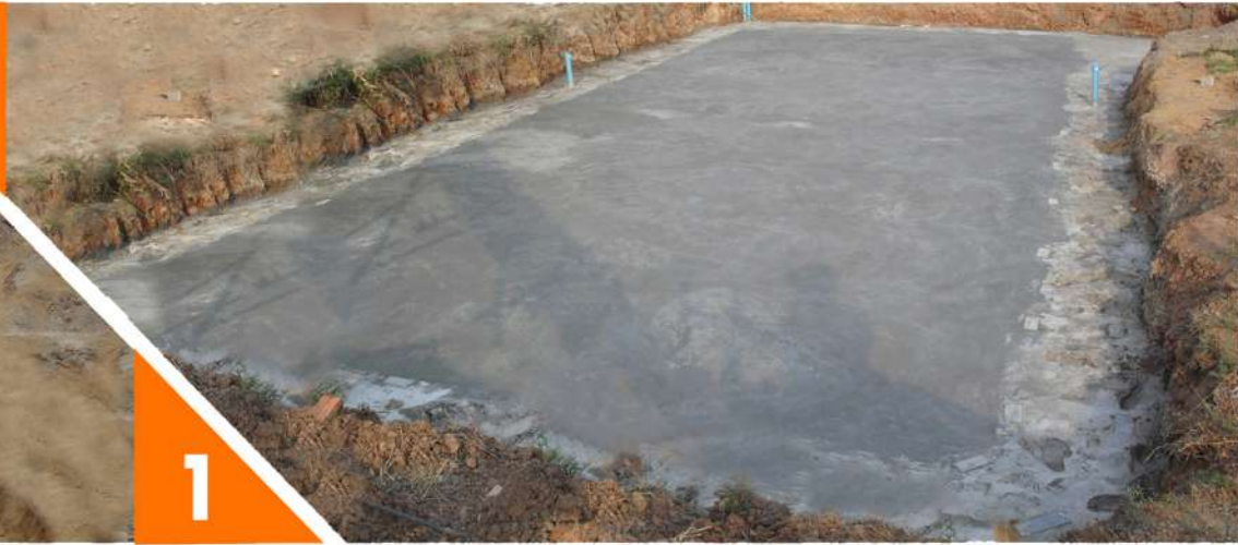
เทลิ้น วางเหล็ก เทคอนกรีต ทำโครงสร้างพื้นคอนกรีตเสริมเหล็ก Pours Lean Concrete , Rebar Work and Reinforced Concrete Slab
